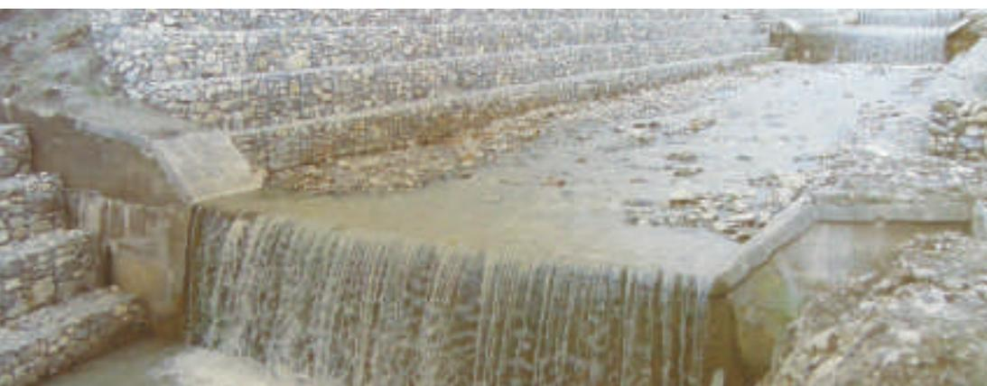
stendendoli preventivamente sui versanti ed ancorandoli con picchetti. Dopo la posa del materiale lapideo di adeguate dimensioni si provvede alla chiusura degli elementi con la posa dei coperchi o attraverso la stesura dei rotoli di rete.
