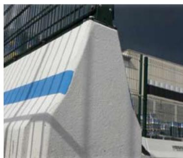
cemento armato vibrato, di sezione 75 cm
