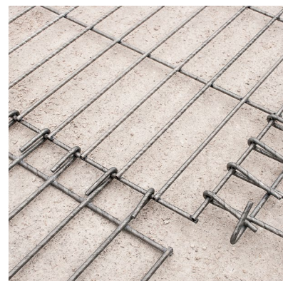
Foto 1 - Particolare posa pannello
